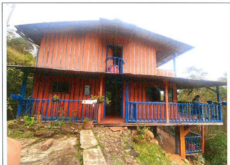
Fotografía 1. de la entrada principal de la infraestructura objeto de la solicitud de adecuación, donde se pueden evidenciar una infraestructura habitacional de 2 niveles el cual se componen principalmente en tabloncillos de madera, dos chambranas en madera, piso en tablas de madera, zonas como el baño en cemento con cerámica, gradas cemento mezclado con piedras, cimentación en madera y piedra y la cubierta es en tejas zinc.
