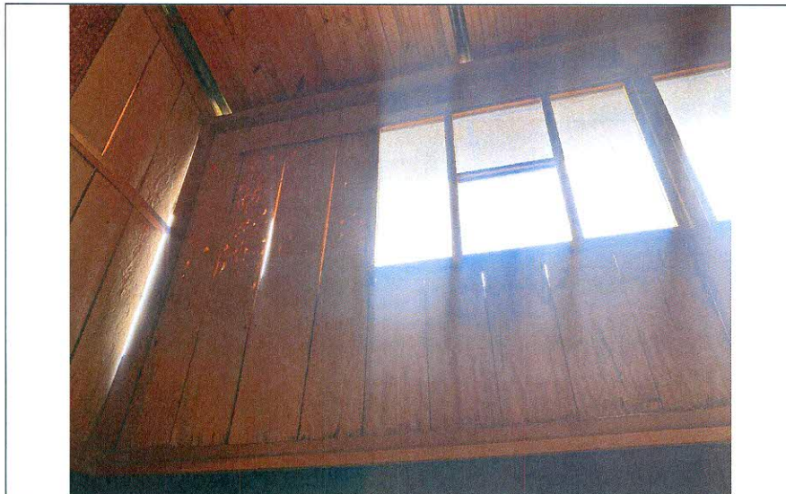
Fotografía 2. Durante la visita técnica se evidencia que una parte de la fachada del segundo nivel se encuentra deteriorada por la polilla el cual ha dejado vacía por dentro la madera causando debilitamiento en esta pared con riesgo de desplome.
